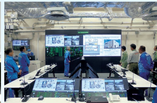
緊急時対策建屋内の視察
