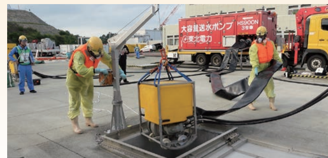
大容量送水ポンプ車を用いた注水訓練
