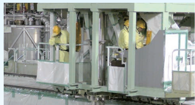
燃料交換機上から燃料の位置などを確認する作業員
