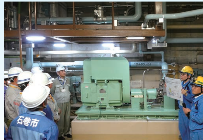
現場確認の様子
