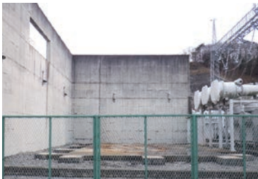
主変圧器（撤去後）
