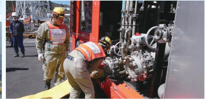
熱交換器ユニット設置訓練
