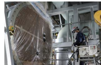
原子炉補機冷却系熱交換器の点検作業
