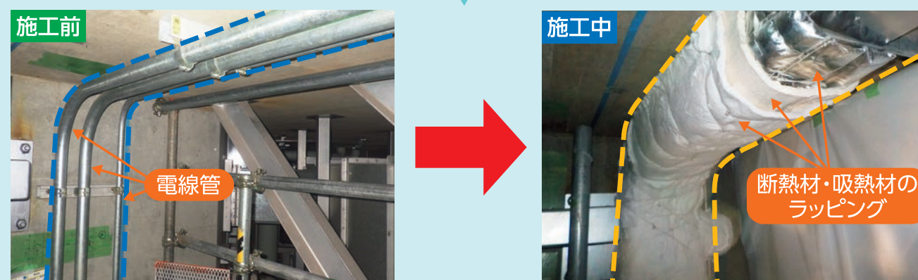
追加で実施している「電線管への耐火材ラッピング工事」
