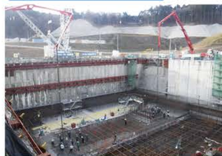
基礎設置工事 (2018年12月撮影)
