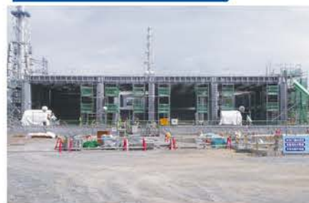
緊急用電気品建屋の建設工事 (2021年5月撮影)
