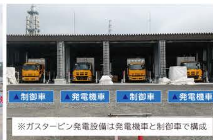
緊急用電気品建屋内に ガスタービン発電設備を設置 (2023年1月撮影)
