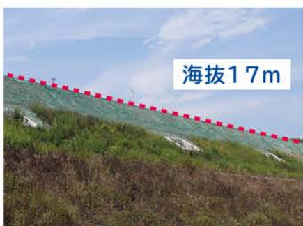
海拔17mの防潮堤 (2012年9月撮影)
