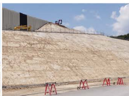
盛土式の堤防設置工事 (2023年6月撮影)
