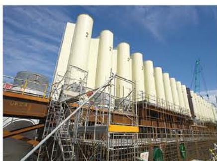
鋼管式鉛直壁設置工事 (2015年4月撮影)
