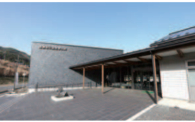
●外壁には津波で流された建物に載っていたスレートが使われています
