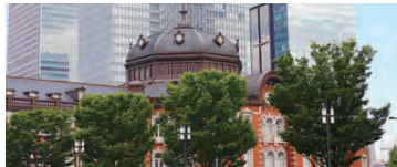
●雄勝産スレートが昔から、創建当時の姿が残った東京駅丸の内駅舎
