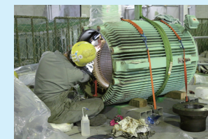
原子炉補機冷却海水ポンプ
