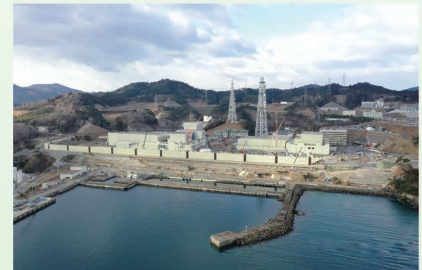
安全対策工事が進む女川原子力発電所の全景(2023年2月撮影)
