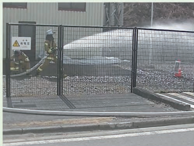
風向きや火災の状況に合わせて的確に放水
