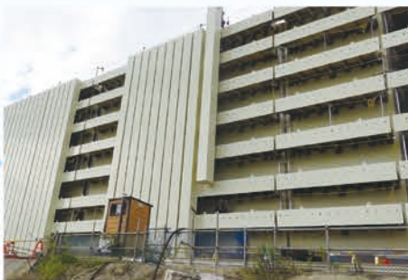
防護工をクレーンで吊り上げて取り付け
