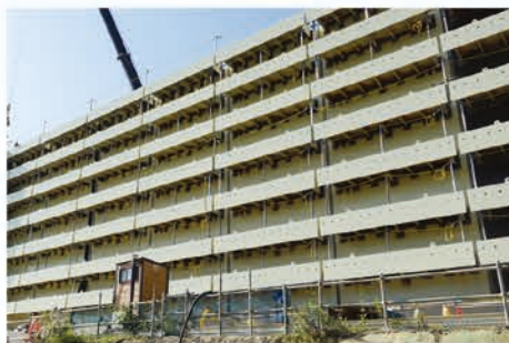
防護工設置前(架台取り付け済)
