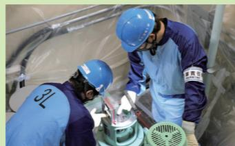
分解したポンプの損耗度合を、1ミリ以下の単位で精密に計測します
