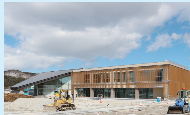
完成間近の立地地域事務所
