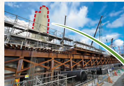
鋼管式鉛直壁の建設が始まる
