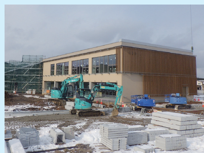
立地地域事務所の工事風景 (1月時点)
