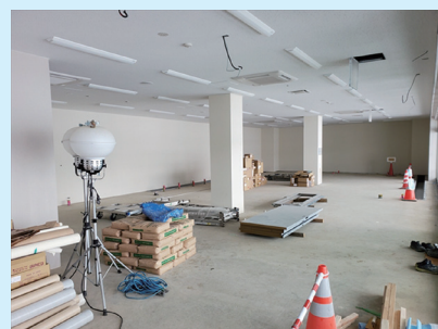
テナントスペースの工事状況 (1月時点)
