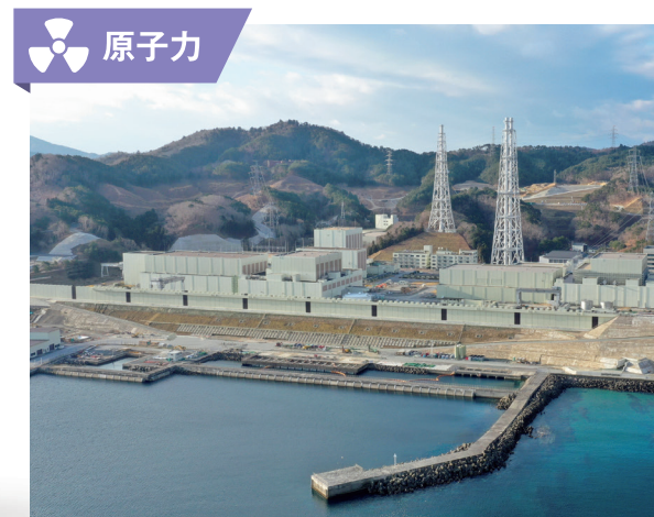
発電時にCO 2 を排出しない原子力発電所。写真は女川原子力発電所(宮城県女川町・石巻市)
