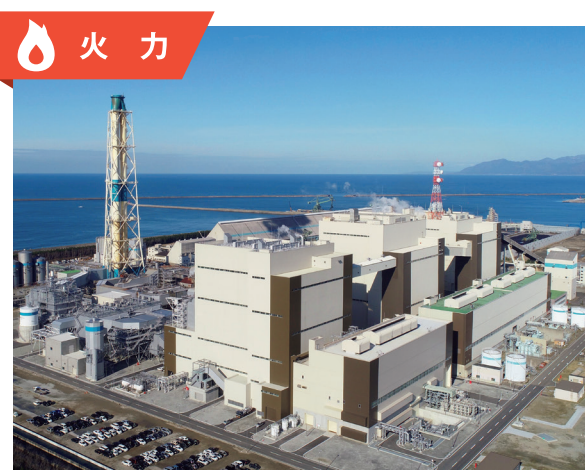
石炭火力の脱炭素化に取り組む能代火力発電所 (秋田県能代市)
