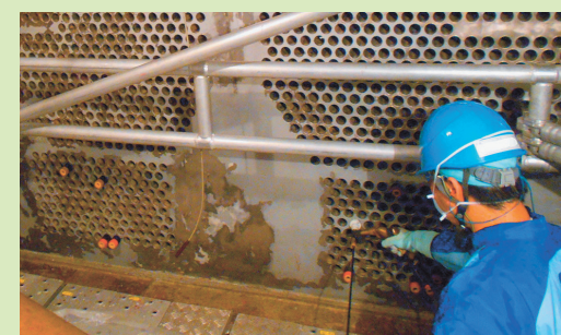
細管に傷がないか点検器具を使い確認
