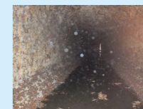
海水を抜き取りしただ後の取水路
