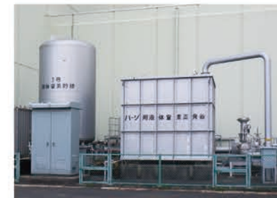
窒素ガス供給装置(撤去前)
