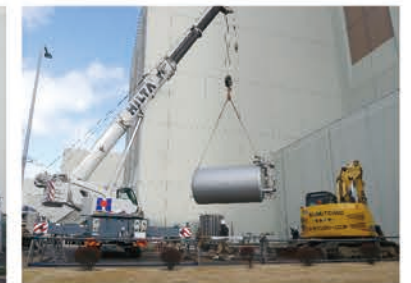
撤去作業の様子
