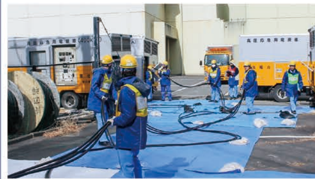
電源車の接続訓練
