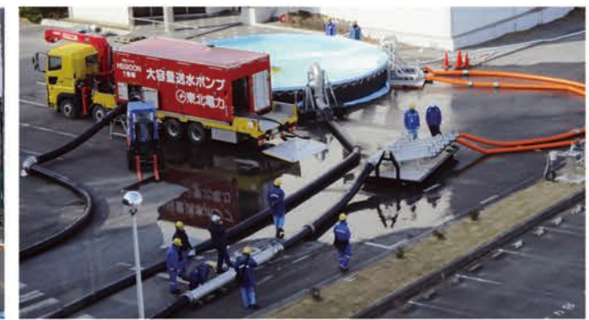
大容量送水ポンプ車による冷却機能確保訓練
