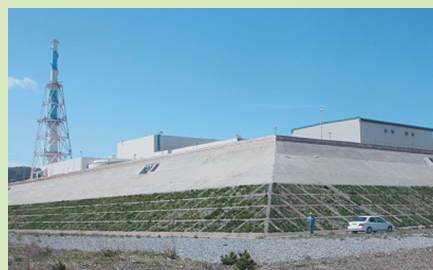
防潮堤 海拔約16mの防潮堤により、津波（想定津波高さ：11.7m）から発電所を守ります。
