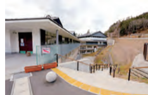
●どの階からも屋外に出られ、山側に避難出来る造りになっています
