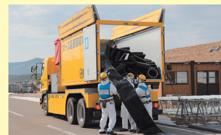
送水ホースの敷設作業
