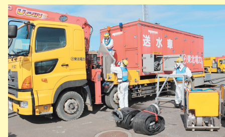
取水口への送水車設置作業
