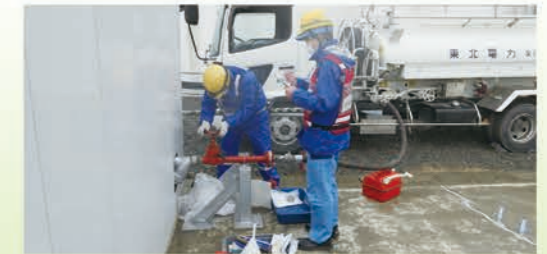
2号機燃料タンクへ燃料を補給
