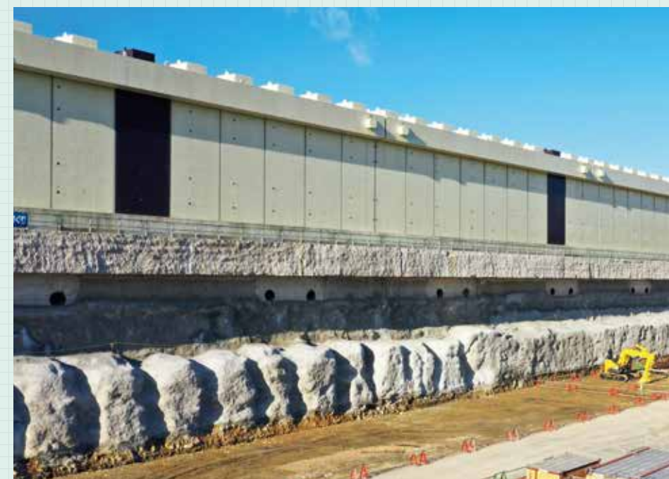
地震等の影響で防潮堤が沈下しないよう、防潮堤下部を地盤改良等で補強する工事を進めています
