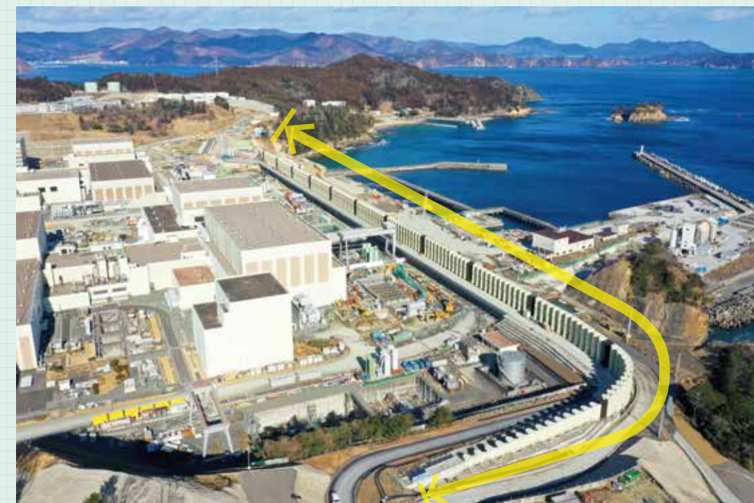
防潮堤の総延長は約800m
