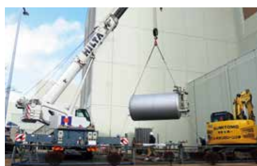
タンクを撤去している様子
