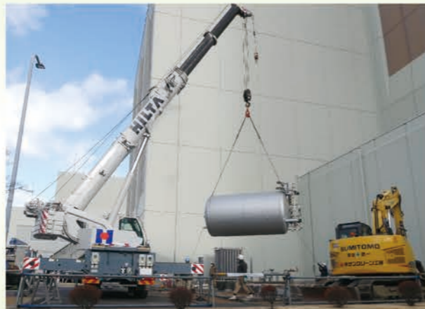
タンクを撤去している様子
