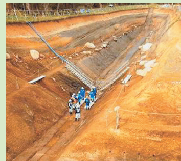
掘削による地質調査
