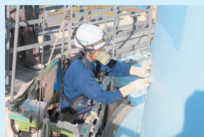
ゴンドラを使った筒身の塗装作業
