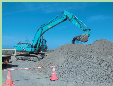
バックホウ操作訓練 (がれきや土砂の撤去)
