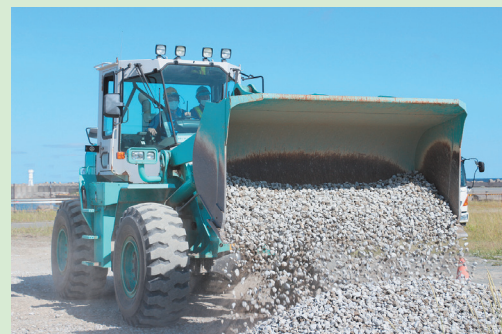
段差を模したコースに砂利をスロープ状に敷設し段差を解消
