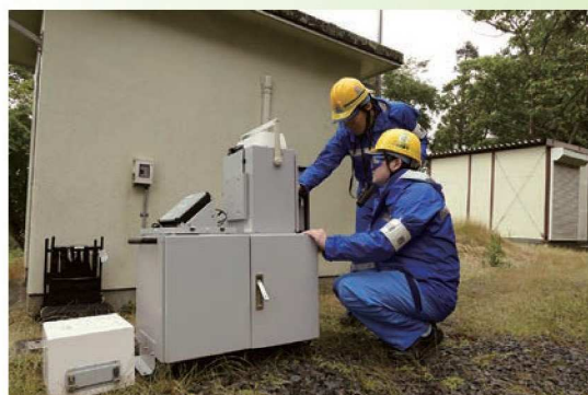
装置を設置し放射線量を測定する様子
