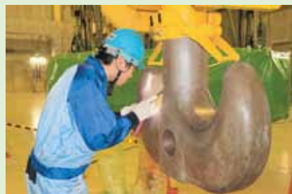
フックの損傷や変形を見落とさないようライトを使用して細部まで確認
