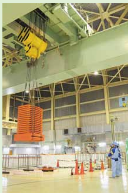
点検用の重りを吊り上げ、クレーンが正しく動作することを確認
