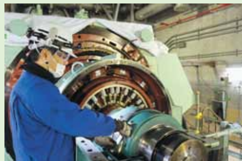
異物の混入に注意しながら適正なトルクでボルトを締め付け
