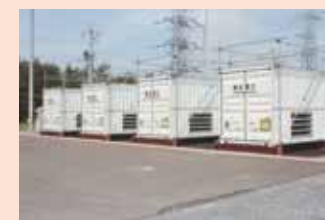
大容量電源装置 ・2011年8月に4台設置済み ・定格出力2,000kVA/台
