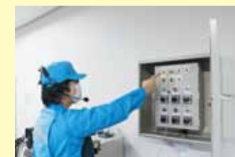
中央制御室内でケーブルを接続
