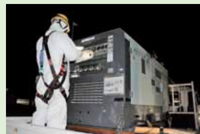
エンジン式コンプレッサーを起動
