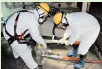
可搬型のポンプに燃料を送るためのホースを取り付け
