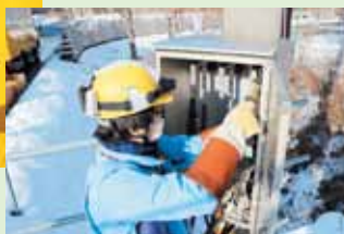
電柱の分電盤へケーブルを接続
