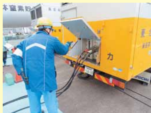
電源を失った発電所設備へ電力を供給するため電源車を接続
