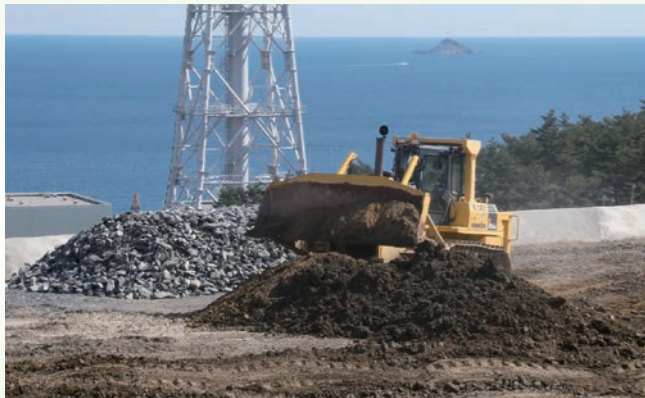
がれき(土砂)を撤去する様子
