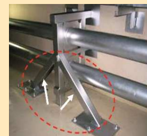
主蒸気配管(左)・建屋内配管(右)の耐震補強
