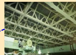
オペレーションフロアの天井(左)・壁面(右)の耐震補強
