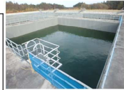
東通原子力発電所 淡水貯水槽
