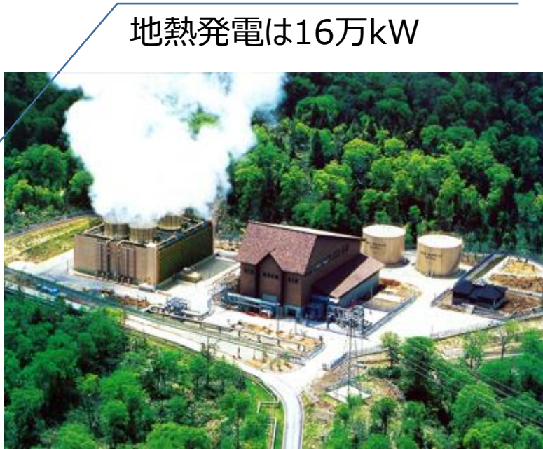
澄川地熱発電所 (秋田県)
