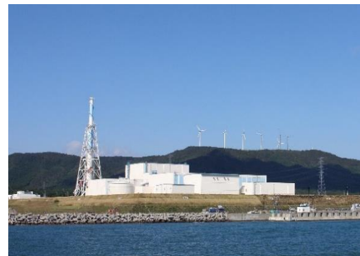
東通原子力発電所（全景）
