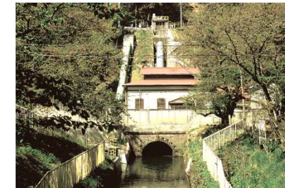
水力 三居沢発電所 (宮城)
