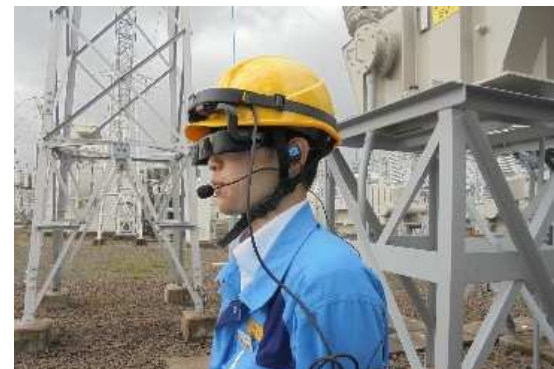
スマートグラスを活用した設備の保守管理
