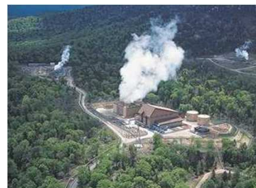
地熱 澄川地熱発電所 (秋田)
