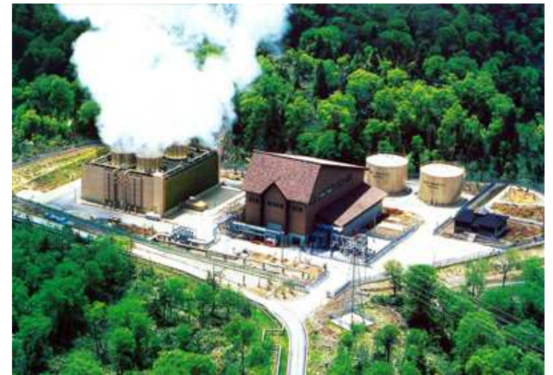
澄川地熱発電所（秋田県）
