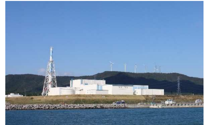
東通原子力発電所（全景）
