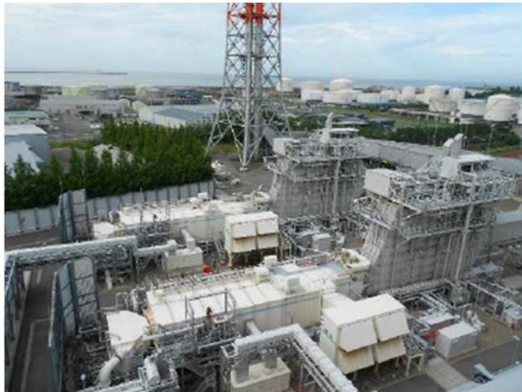
新潟火力発電所 5号系列
