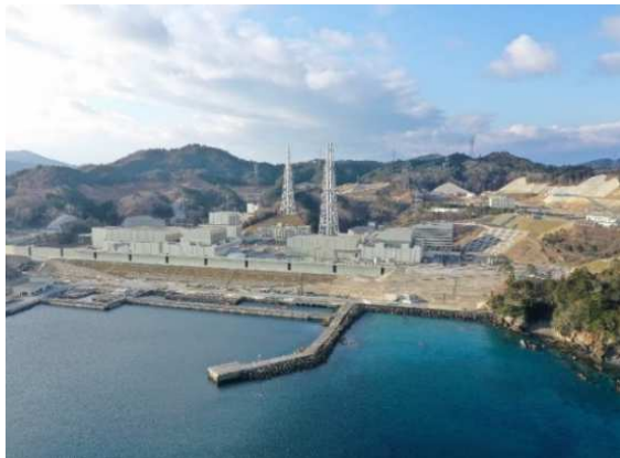
女川原子力発電所（全景）
