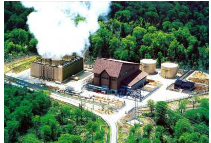
澄川地熱発電所 (秋田県)
