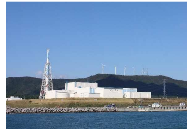
東通原子力発電所（全景）
