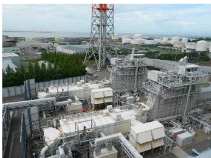
新潟火力発電所 5号系列
