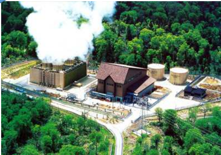
澄川地熱発電所 (秋田県)
