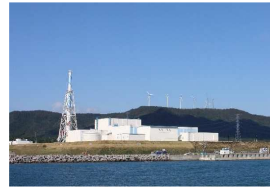
東通原子力発電所（全景）
