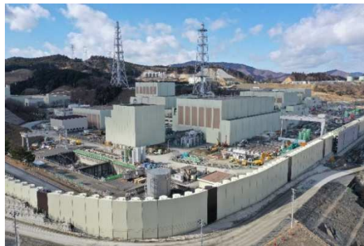
工事が進む女川原子力発電所の 海拔2.9mの防潮堤
