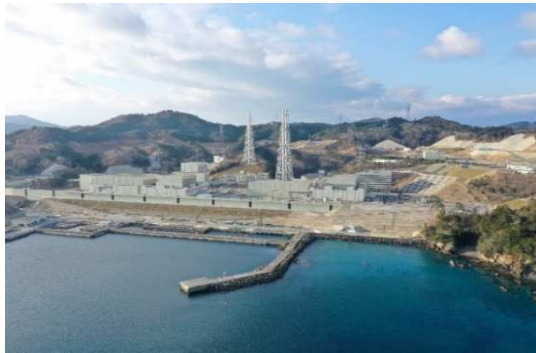
女川原子力発電所（全景）
