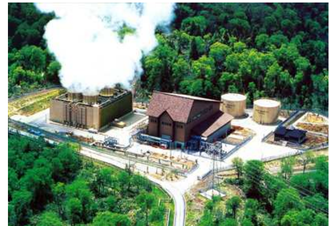
澄川地熱発電所（秋田県）
