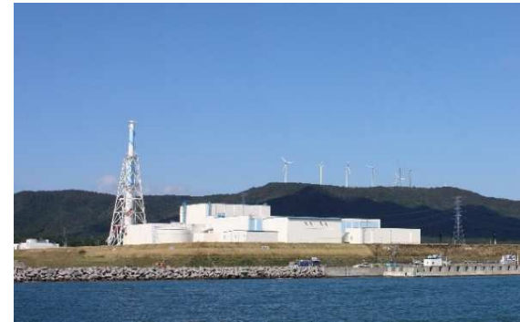
東通原子力発電所（全景）
