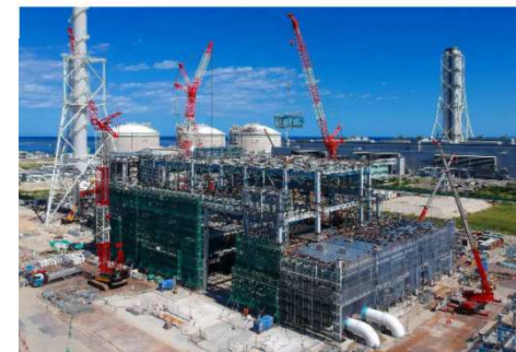
上越火力発電所1号機の建設工事の様子 (2020年9月現在)
