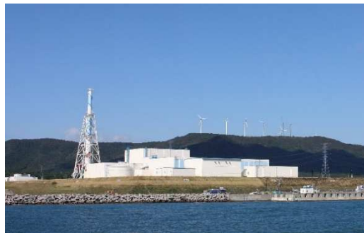
東通原子力発電所（全景）
