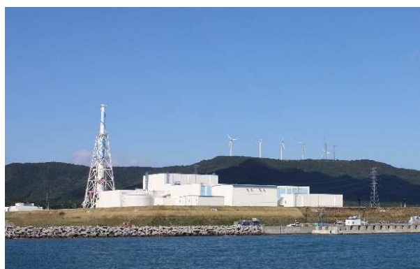
東通原子力発電所（全景）
