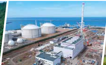
上越火力発電所第1号機(建設中)
