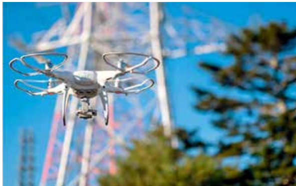
ドローンによる送配電設備の点検
