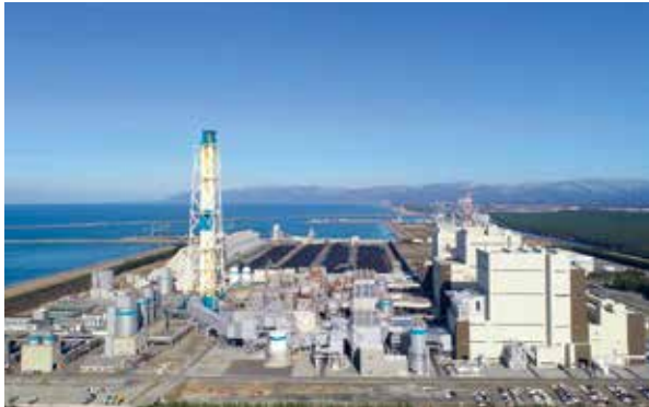
能代火力発電所
