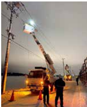
暴風雪による停電復旧の様子
