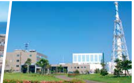
東通原子力発電所
