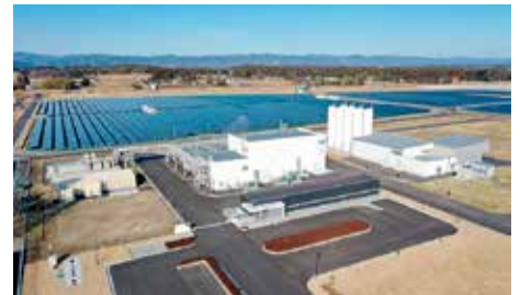
福島水素エネルギー研究フィールド (新エネルギー・産業技術総合開発機構から事業を受託)
